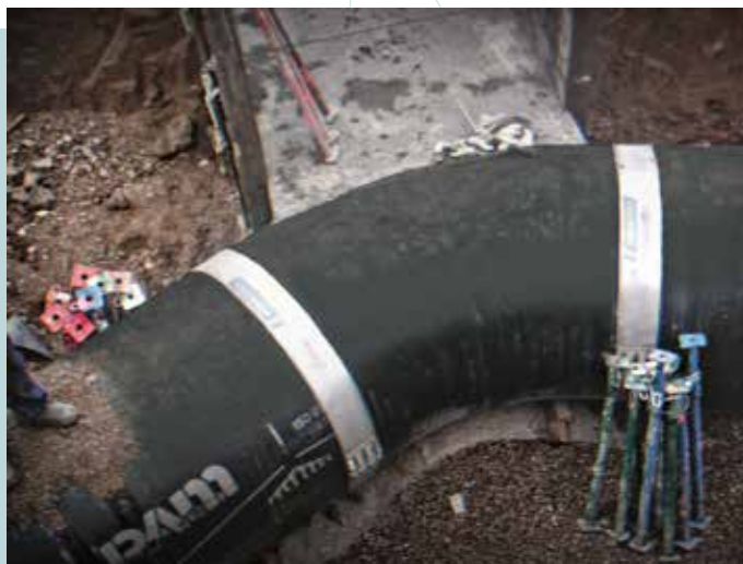
Fig. 4 / Montagem de curva em tubagem de fundição.
