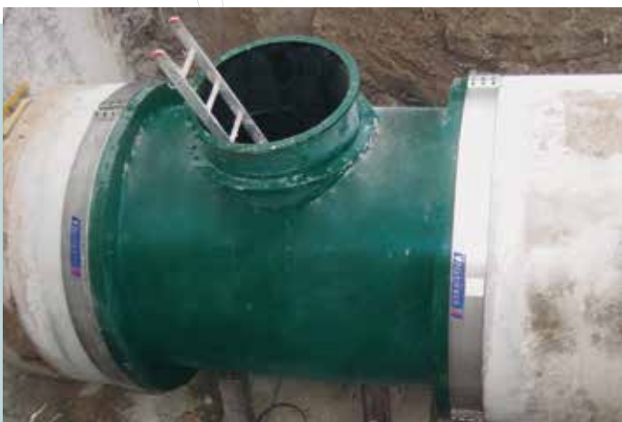
Fig. 5 / Instalação de registro de inspeção para tubagem de grande diâmetro.
