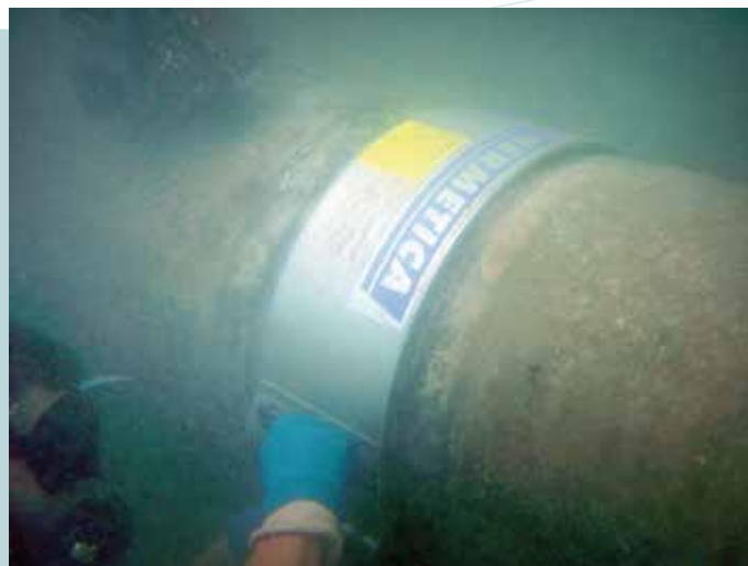
Fig. 2 / Montagem subaquática. Abraçadeira HERMETICA SF fabricada em aço inoxidável Duplex.
