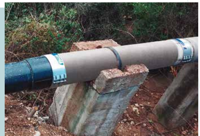
Fig. 6 / Reparação da tubagem aérea com diferentes materiais e diâmetros.
