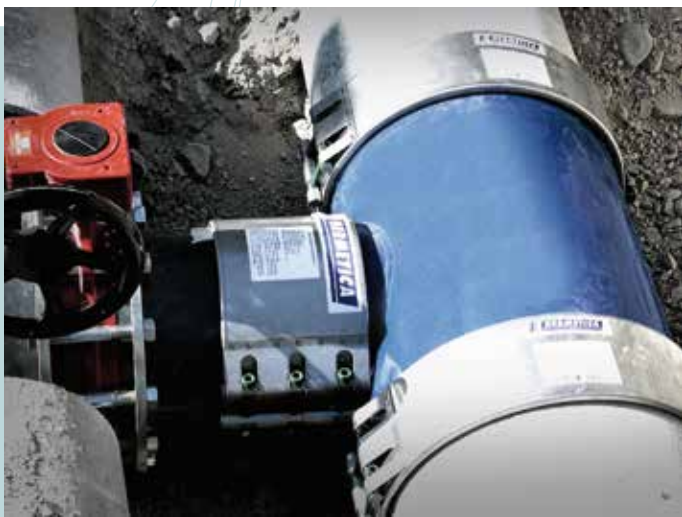
Fig. 3 / Montagem de tubagem e acessórios em diferentes materiais.
