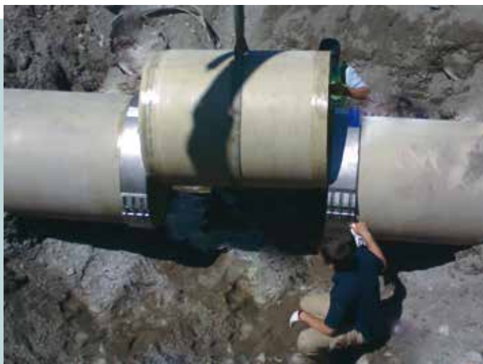
Fig. 1 / Reparação com novo troço de tubagem de grande diâmetro em PRFV.
