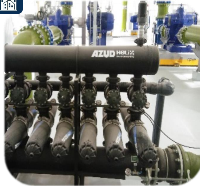
4 x AZUD HELIX AUTOMATIC FT4DCL5 1.120 m 3 /h | 50 µm | Dubai Parque de atracciones IMG Worlds of Adventure
