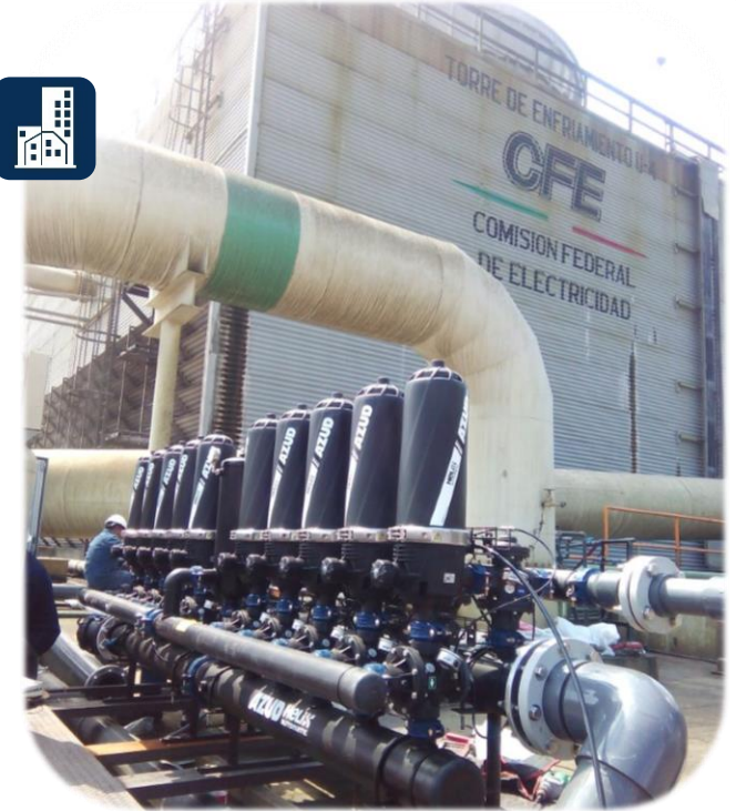
1 x AZUD HELIX AUTOMATIC FT210 AA 150 m 3 /h | 50 µm | México Comisión Federal Electricidad - CFE
