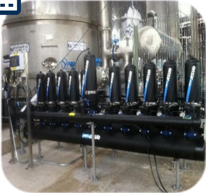
2 x AZUD HELIX AUTOMATIC 210 AA 500 m 3 /h | 200 μm | Chile Coca-Cola fábrica embotelladora
