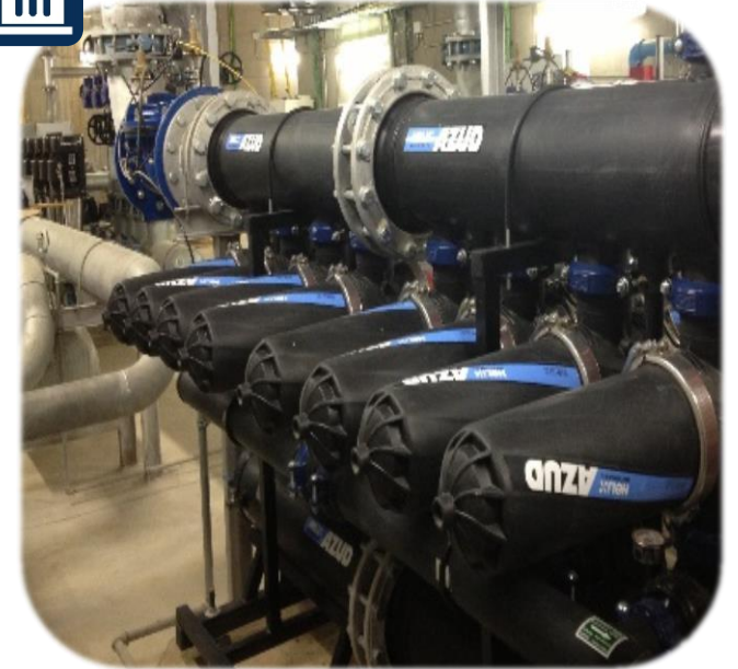
2 x AZUD HELIX AUTOMATIC 4DCL8 700 m 3 /h | 130 μm | España Ciudad Financiera Boadilla del Monte
