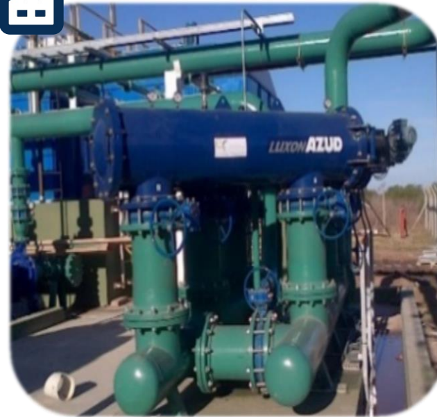
3 x AZUD LUXON LXE 13200 S/12 750 m 3 /h | 50 µm | Argentina General Motors fábrica de coches
