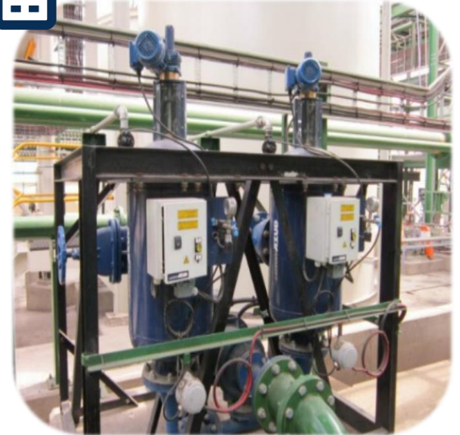
2 x AZUD LUXON LDB 5400 S/6 80 m 3 /h | 20 µm | África Mina de oro
