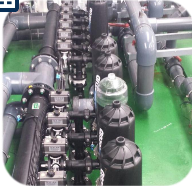
2 x AZUD HELIX AUTOMATIC 706 SW 60 m 3 /h | 5 µm | Portugal Cosecha de algas para biofuel
