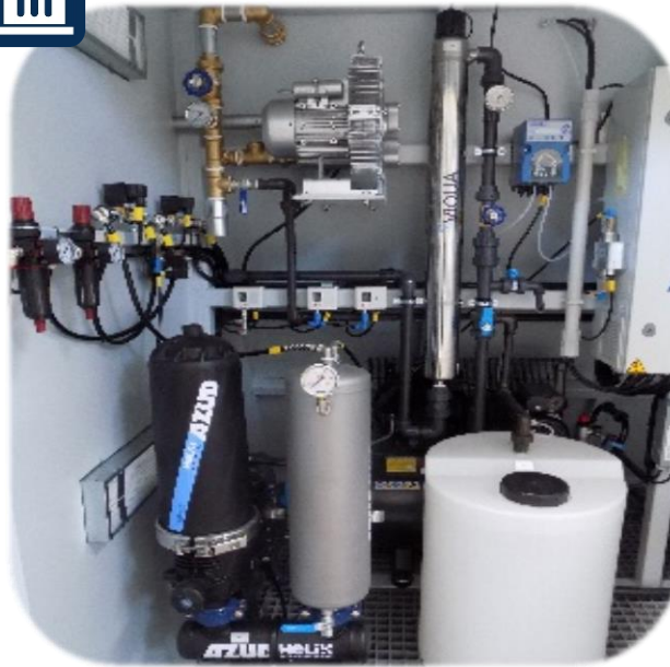
1 x AZUD HELIX AUTOMATIC 201 AA 6 m 3 /h | 20 μm | Panamá Villas Coco De Mar reúso de agua
