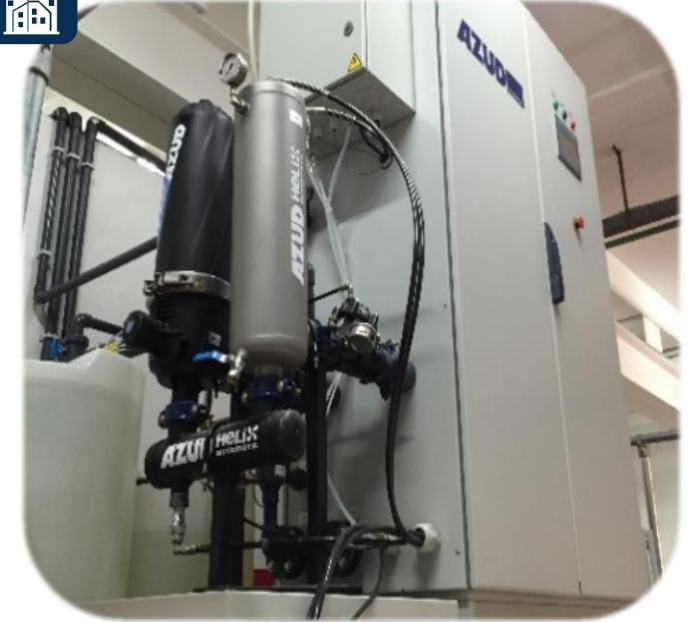
1 x AZUD HELIX AUTOMATIC 201 AA 6 m 3 /h | 100 μm | Malta Piscina nacional de Malta
