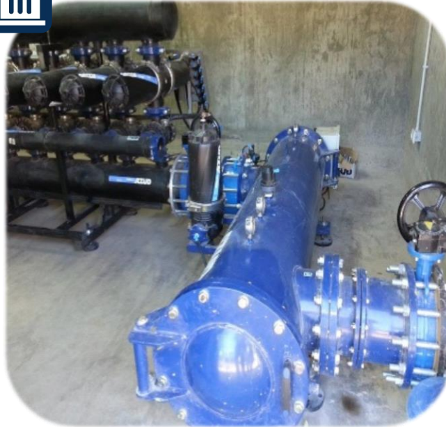
1 x AZUD LUXON LXE 13200 S/10 123 m 3 /h | 100 μm | Argentina Nogoli San Luis embalse de almacenamiento
