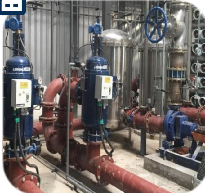
6 x AZUD LUXON LDB 4800/8 100 m 3 /h | 50 μm | China Zhongguan acería
