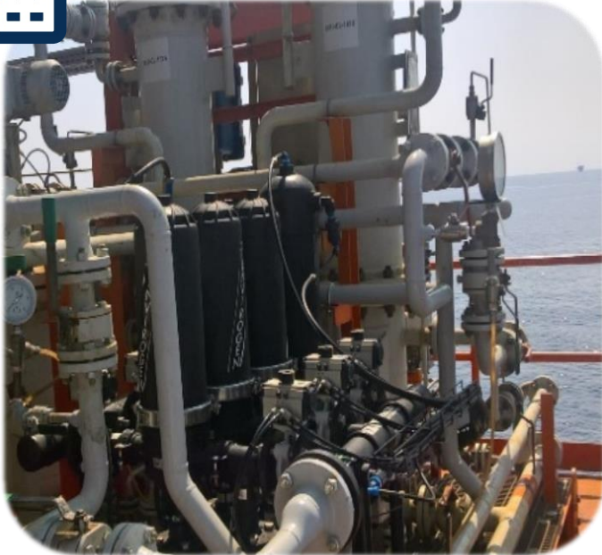
1 x AZUD HELIX AUTOMATIC 703 SW AA 15 m 3 /h | 10 μm | Italia ENI Ancona plataforma petrolífera
