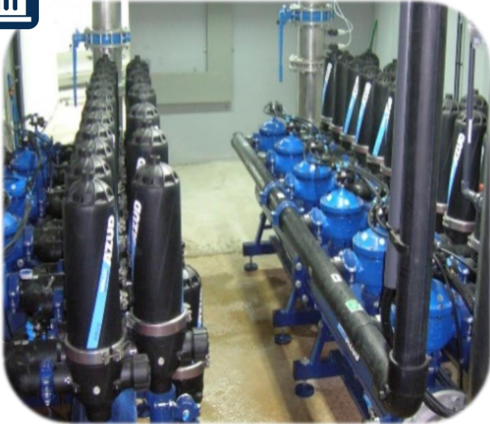
2 x AZUD HELIX AUTOMATIC 406 720 m 3 /h | 130 μm | España Barcelona Montjuic Fuente Mágica
